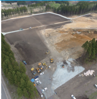
太陽光発電所 敷地造成工事 Photovoltaic power station/ Site Preparation
