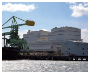
原町火力発電所復旧工事 Repairs to Haramachi Thermal Power Plant
