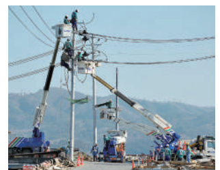
南三陸町における建柱作業 Pole construction work in Minamisanriku-cho
