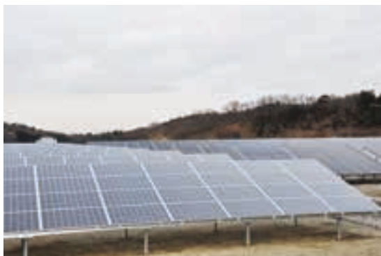
富谷石積太陽光発電所（宮城県黒川郡富谷町） 〔太陽光発電設備工事〕
