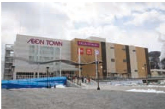
イオンタウン釜石 (岩手県釜石市) 〔電気設備、空調・給排水・衛生設備工事〕
