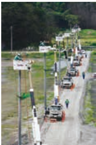
長面・尾崎地区配電復旧工事（宮城県石巻市） ※被災地の配電設備の全復旧に向けた最後の工事（東京電力株式会社福島第一原子力発電所の事故の帰還困難区域を除く。）
