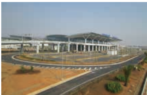
ノイバイ国際空港 (ベトナム国ハノイ市) 〔電気設備工事〕
