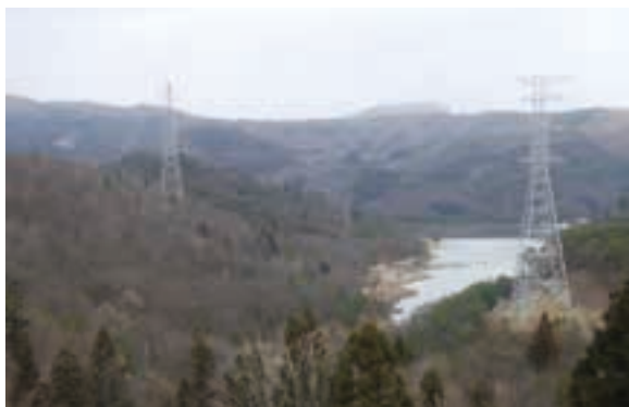
南山形幹線新設工事（山形県上山市ほか）
