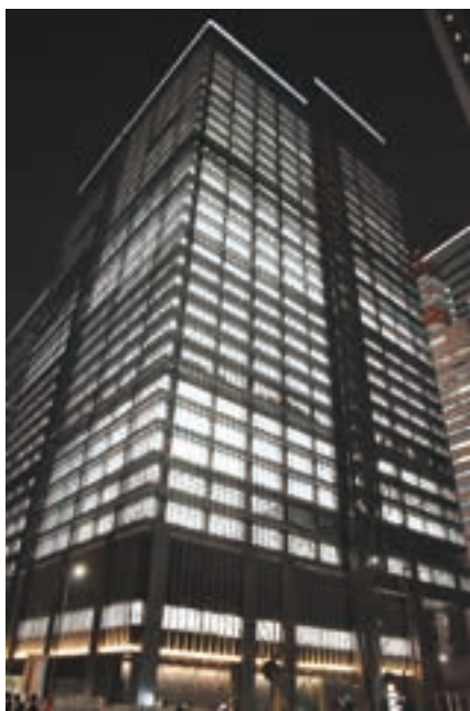
大手町フィナンシャルシティグランキューブ（東京都千代田区） 〔電気設備工事〕
