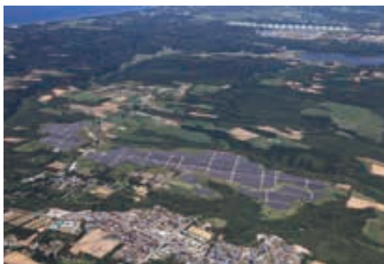
ユース六ヶ所ソーラーパーク（青森県上北郡六ヶ所村） 〔太陽光発電設備工事〕
