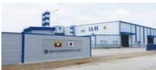
I&Hプレキャストコンクリート工場新築工事（ミャンマー国ヤンゴン市） 【電気設備、空調・給排水・衛生設備工事】
