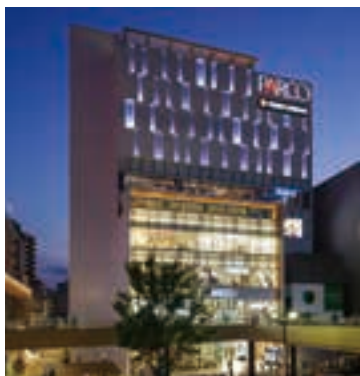
仙台PARCO 2（宮城県仙台市） 〔電気設備、空調・給排水・衛生設備工事〕
