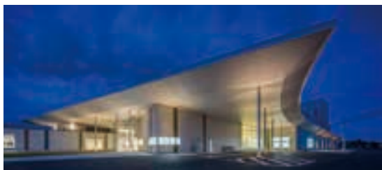
ビッググループ滝沢（岩手県滝沢市） 〔電気設備工事〕
