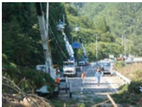
平成28年台風10号の復旧工事（岩手県久慈市）
