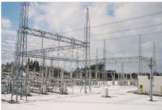
東北電力五戸変電所 (青森)
