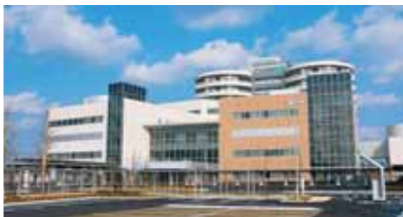
新潟市民病院（電気設備工事：新潟）
