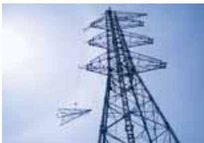
十和田・北上幹線（送電工事：青森・岩手・宮城）
