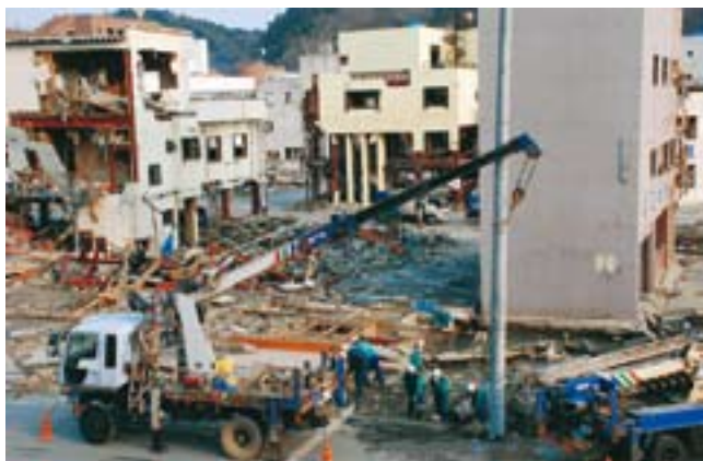
三陸沿岸の被災地に新たな配電柱を建てる当社作業員 （宮城県牡鹿郡女川町）
