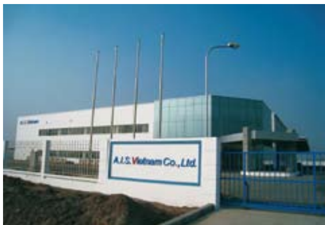
A.I.S ベトナムコーポレーション新築工事 (屋内配線・空調管設備工事)
