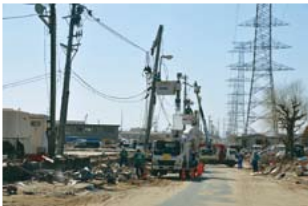
倒壊・折損などした被災地の配電柱を撤去する当社作業員 (仙台塩釜港付近)
