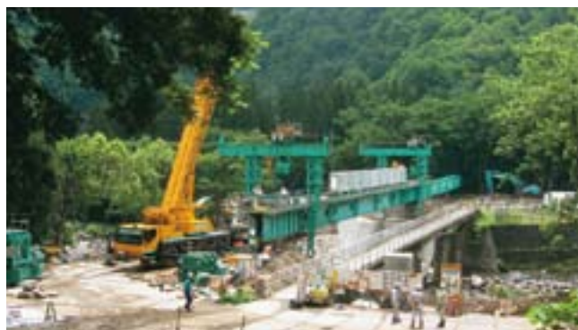
鳥海川第二発電所専用道路橋取替工事（土木工事）
