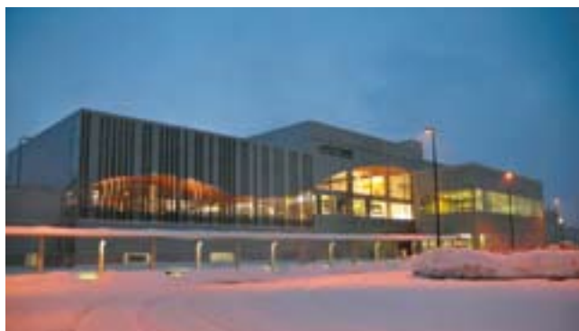
東北新幹線「七戸十和田駅」電灯電力設備工事（屋内配線工事）
