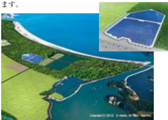
奥松島「絆」ソーラーパーク 全体イメージ図（宮城県） 〔太陽光発電設備工事〕
