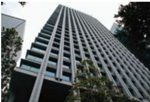
大手町フィナンシャルシティサウスタワー（東京都） 〔電気設備工事〕
