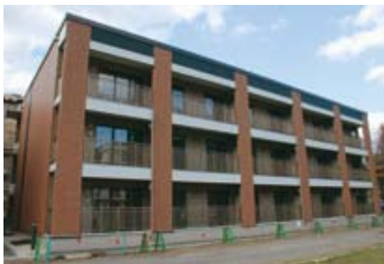
釜石市復興公営住宅（岩手県） 〔電気設備、空調・給排水・衛生設備工事〕
