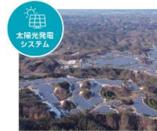
二本松太陽光発電所（NRE） （福島県）
