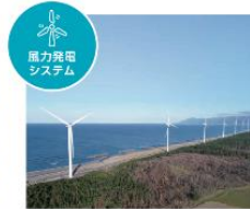
八峰風力発電所 （秋田県）
