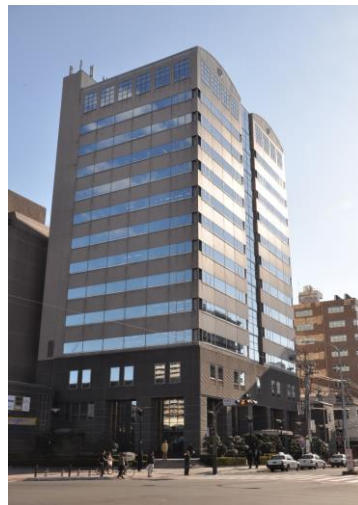
本社ビル 宮城県仙台市(仙台駅東口)
