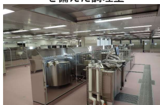
天井換気システム（写真上部） を備えた調理室
