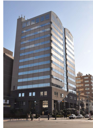
本社ビル 宮城県仙台市(仙台駅東口)
