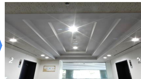
LED照明器具への更新 [屋内配線工事]
