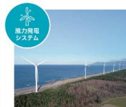
八峰風力発電所 (秋田県)
