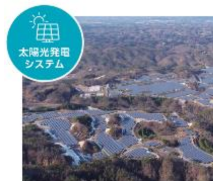
二本松太陽光発電所 (NRE) (福島県)
