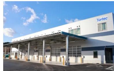
2026年 2 月竣工 当社宮古営業所 外観
