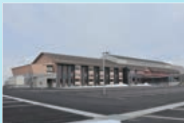
じげんプラザ 福島県大沼郡会津美里町 電気設備工事
