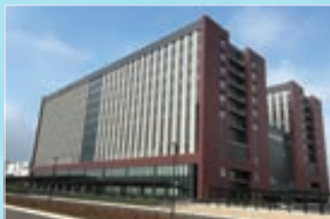
岩手医科大学附属病院 岩手県紫波郡矢巾町 電気設備工事
