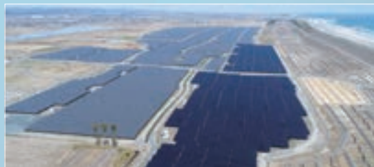
亘理太陽光発電所 宮城県亘理郡亘理町 太陽光発電設備工事
