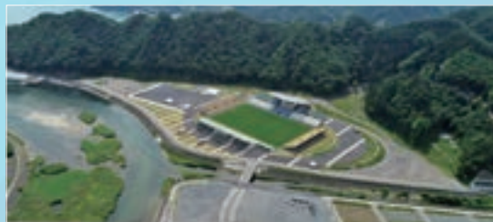
釜石鵜住居復興スタジアム 岩手県釜石市鵜住居町 電気設備工事
